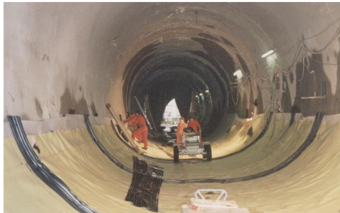
Instalació de Water Stop en la losa
