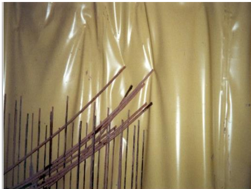
Barras de refuerzo que ponen en peligro el sistema de impermeabilización Encofrado de hormigón
