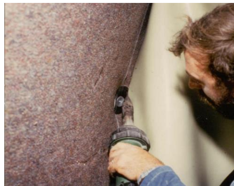
Fijación de la Geomembrana a través de la soldadura directa
