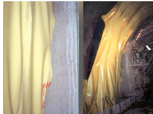
Barras de refuerzo que ponen en peligro el sistema de impermeabilización Encofrado de hormigón
