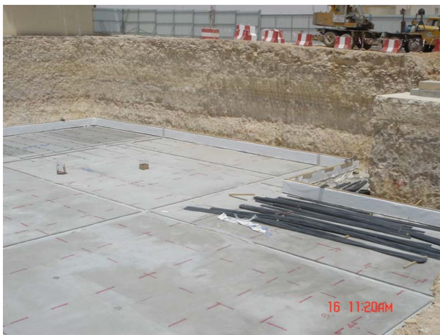
Radier avec des bandes d'arrêts d'eau
