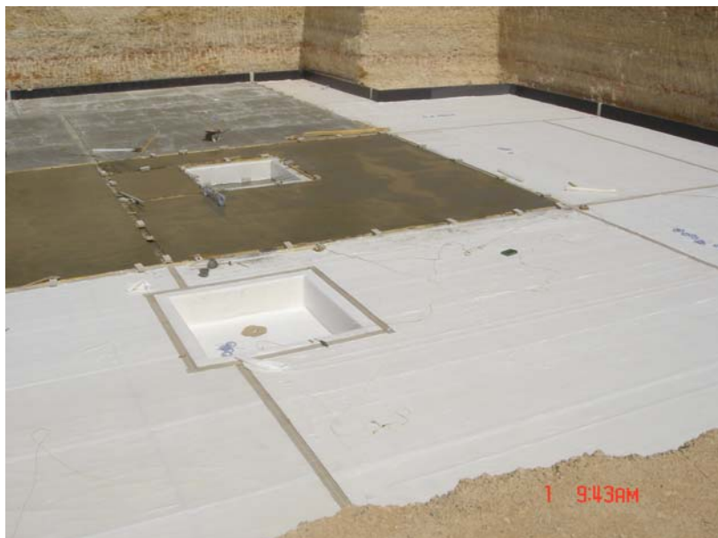
Mise en œuvre du béton de protection
