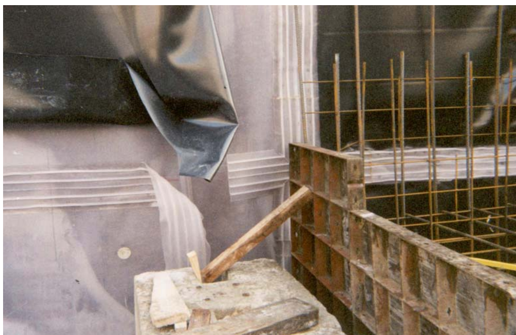
Installation des bandes d'arrêt d'eau
