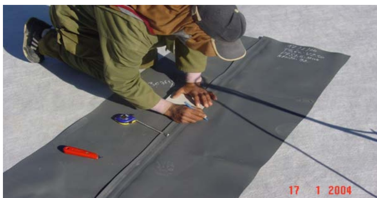
Prueba de soldadura
