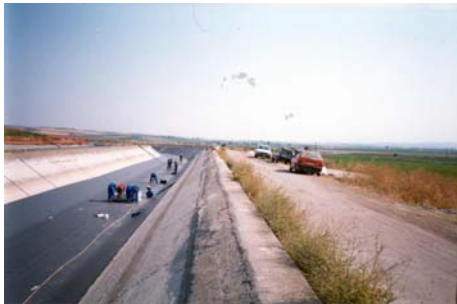
Soldadura con aire caliente y unión doble
