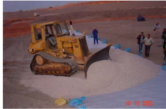
Descarga del material de protección con camión. Distribución del material con una excavadora
