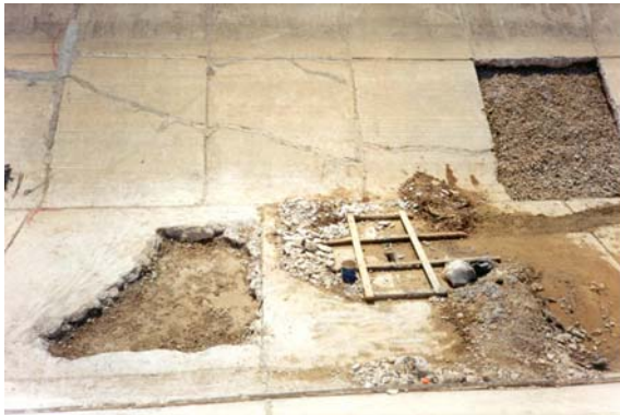
Reparación del lecho del canal viejo y limpieza del sustrato
