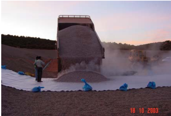
Descarga del material de protección con camión. Distribución del material con una excavadora
