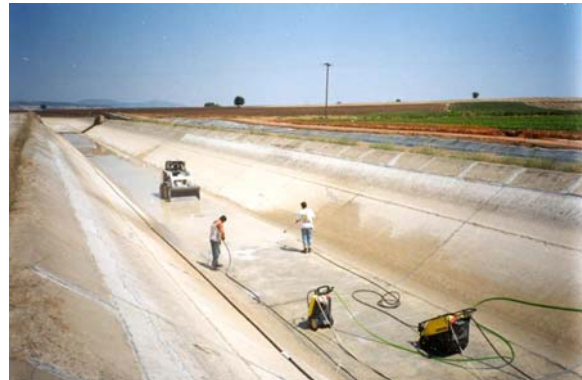
Reparación del lecho del canal viejo y limpieza del sustrato
