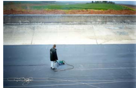
Soldadura con aire caliente y unión doble
