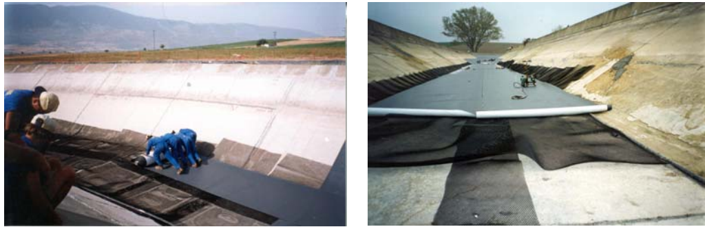
Desenrollando y colocando la geomembrana
