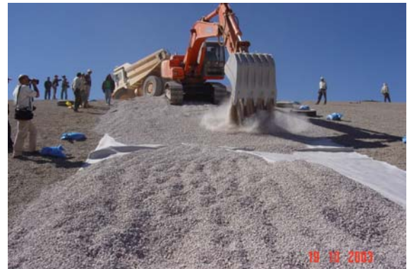
Distribución con excavadora
