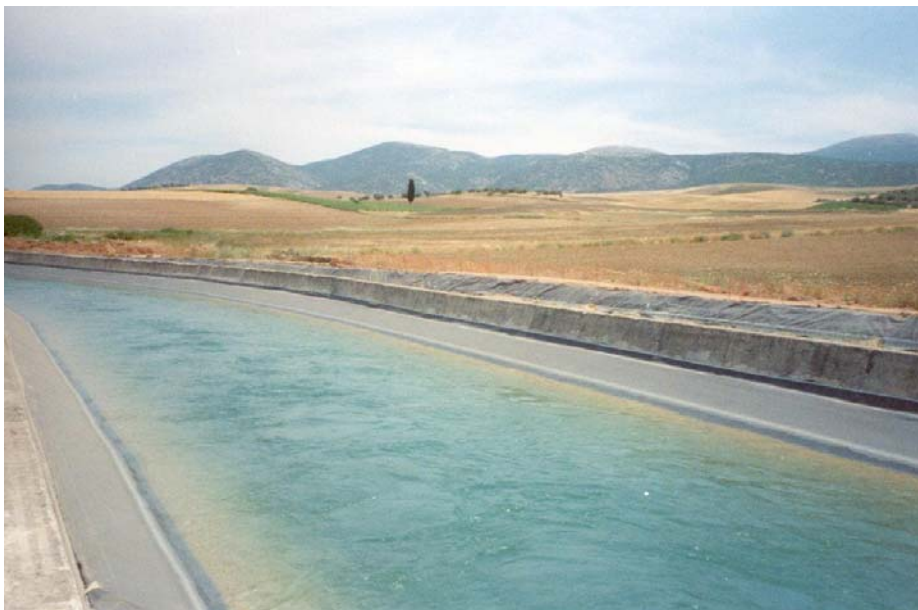
Suministro de agua potable para la Ciudad de Atenas – Canal de Mornos
