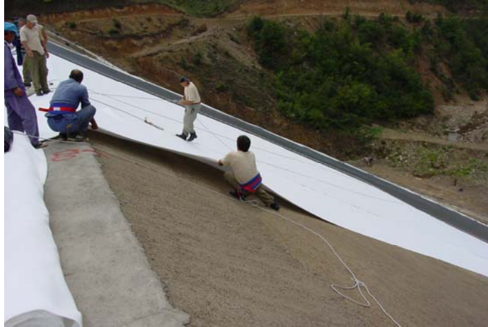
Colocación del geotextil
