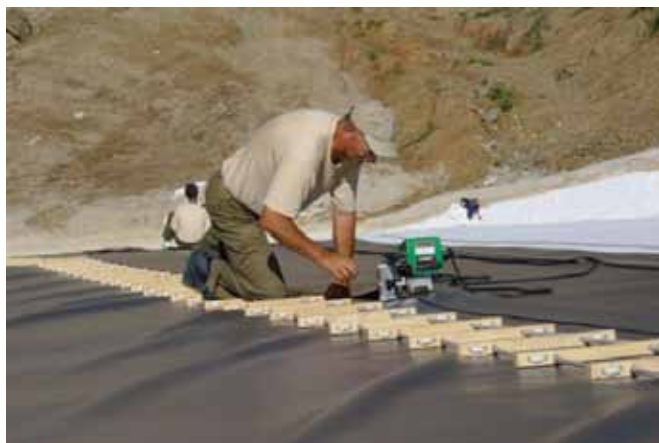
Déroulage et mise en place de la géomembrane
