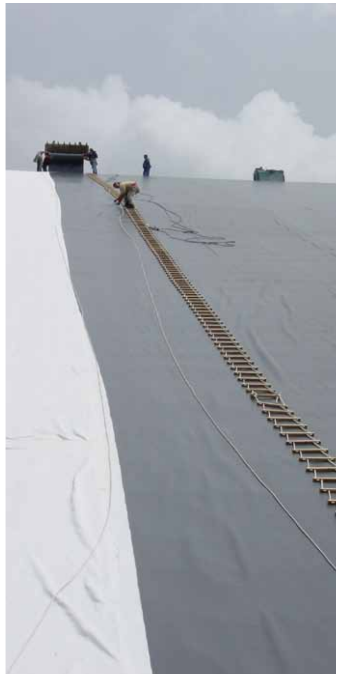
Soudure à air chaud par appareil à double soudure
