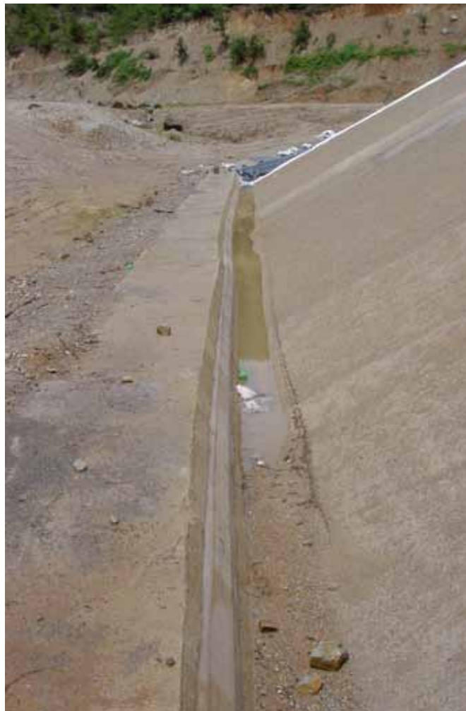
Fixation mécanique au pied du barrage
