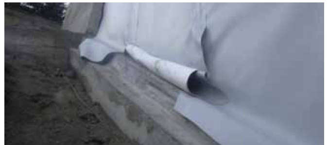
La connexion à la structure en béton à l'aide de bride / contre bride
